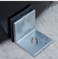
止め金具 (アンカーボルトは M12)
