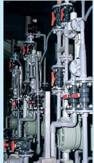
水処理用薬剤を注入するための薬液配管装置
