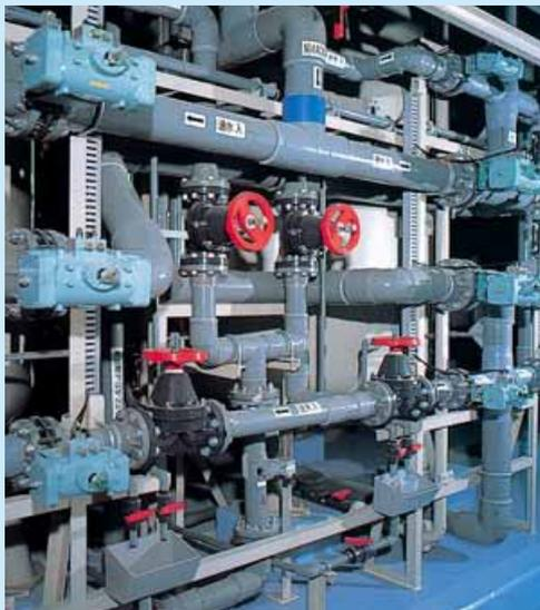
エレクトロニクス工場で水処理装置に使われたエスロンバルブとエスロンVFPWパイプ
