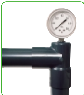
圧力計や温度計などの各種センサーの取り付け。
